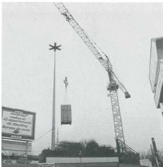
Travaux dans le Centre Ville.
