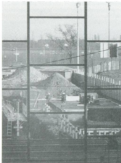
Vue de l'hôtel en construction, depuis le centre Paray-Athis.
