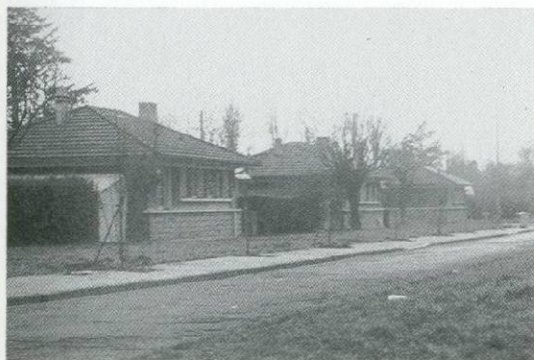
Réfection des trottoirs à la Cité de l'Air.
