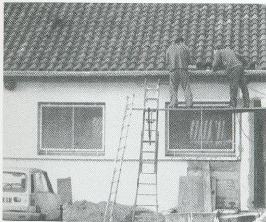
La halte-garderie de la Cité de l'Air, en réaménagement.
